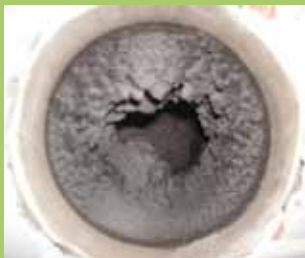
Verunreinigtes Abluftleitung
