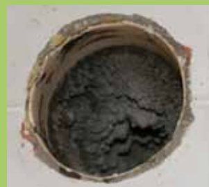
Verunreinigtes Lüftungsrohr
