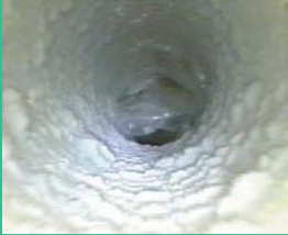
Verunreinigte Abluftleitung im Krankenhaus OP
