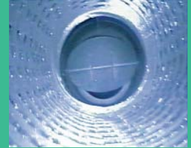
Abluftleitung nach der Reinigung
