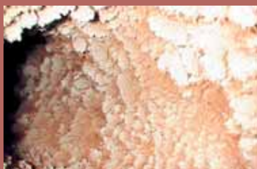
Ablagerungen im Luftkanal
