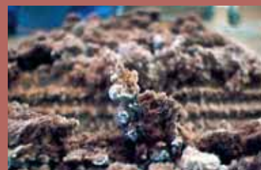
Ablagerungen im Luftkanal
