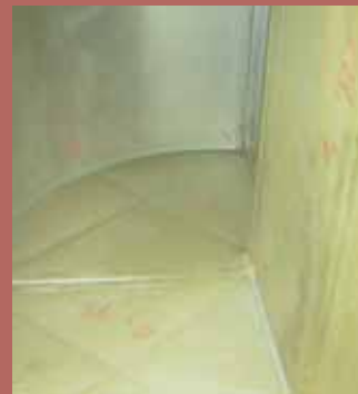
Lüftungskanal nach der Reinigung
